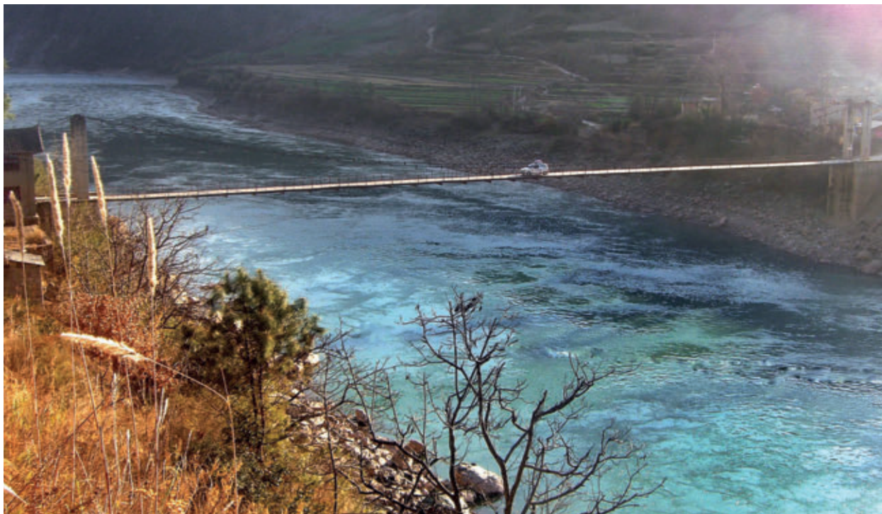
Das Befahren der Brücken erfordert Mut
